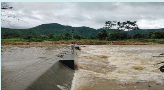
Đường ống qua suối khi nước lũ tràn qua
